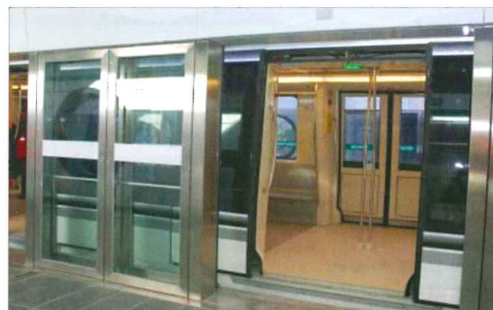
Рис. 12. Автоматические двери на станции линии С
